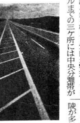
京釜高速道路の増設工事の様子
