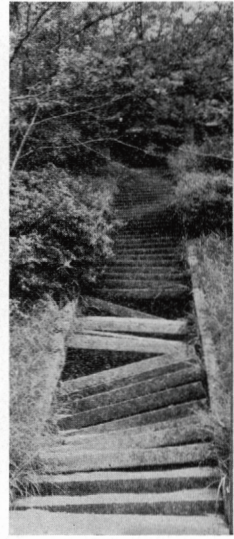
水害にあった参道
