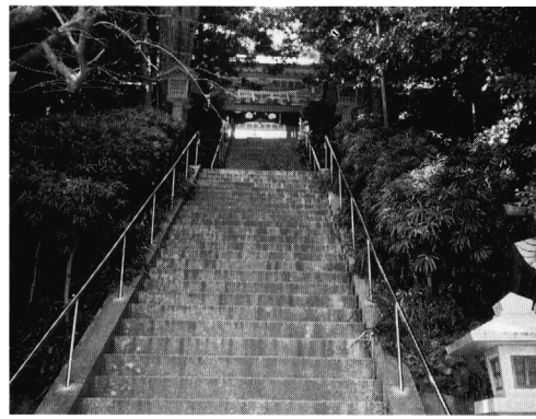
参道石段手摺り付け
