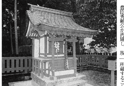
北野天満宮内「宗像社」御社殿の造り替え 九州の太金府天満宮と共に菅原重忠公を祀る神社の双壁とされるお社が、京都市上京区に鎮座されている北野天満宮である。 豊臣秀頼公が再建し、現在最古の権現造り社殿として国宝となっている本殿。同じく国宝で、昨近の「天神様の美術展」でも目玉とされた「北野天神縁起」を所蔵することで有名なお社である。 この北野天満宮の絵馬所の西側、大杉社と背中あわせに当社社である「宗像社」が鎮座されている。 御由緒は「明治維新前、社殿の西の池に五輪塔があり、水底に弁財天が祀られていた」との伝承があり、明治に入って五輪塔を取り除いて社殿を造営し、宗像云神をお祀りしている。 今、永年の風雨に痛んだ御社殿を造り替えることとなり、銅版葺の屋根
