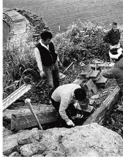
沖ノ島参道修復工事 美事他、一隻の船に便乗し、一路沖ノ島へ。 沖ノ島が真近になる頃、激しい雨波も出て時化の兆し。何んとか上りて欲しい。一念に天祐有りてか、通り雨でホッとす。 搭乗と同時に資材の搬出、プロック、セメント、砂、石、ミキサー等々。何しろ動力は一切無い。人力にて小高い参道、人力にて道作り、力に任せて上げたり、力自慢に運んだり、休む間も無く資材を運び上げる。一息ついたところで、
