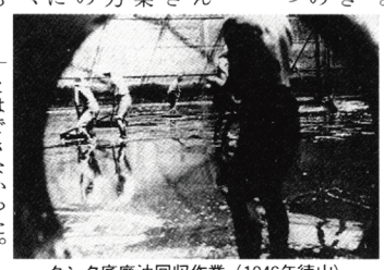
タンク底廃油回収作業 (1946年徳山)
