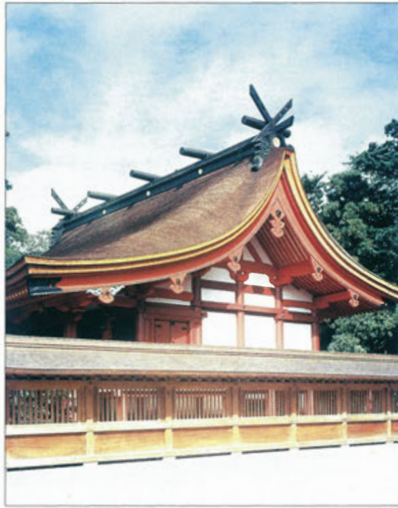
工事完了直後の辺津宮本殿
