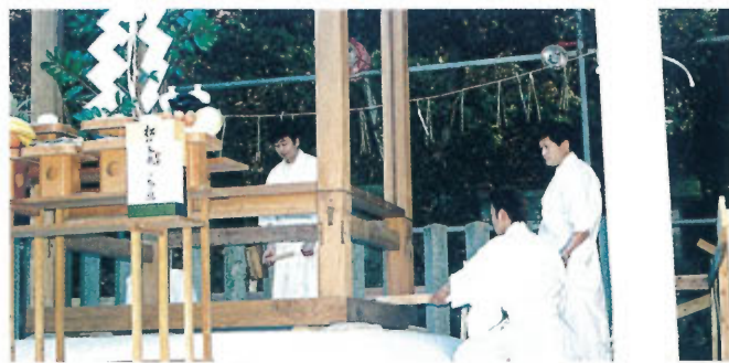
施工業者らによる立柱の儀
