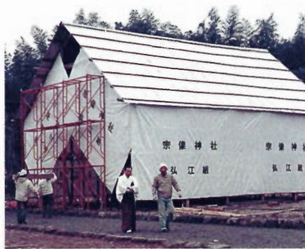
建設中の御社殿(昭和49年)
