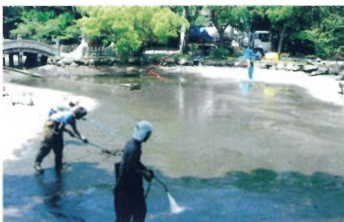
池底二ヶ所に枡を作り、そこにポンプを設置、堆積した汚泥を直接吸い上げ濾過槽で処理し、池に戻すという循環システムを整えた。更に浄化作用のあるホテイアオイを今まで以上に池に増殖させるようにした。これにより堆積する汚泥は減少、下層の水も循環し水質悪化は防ぐことが可能となる。
