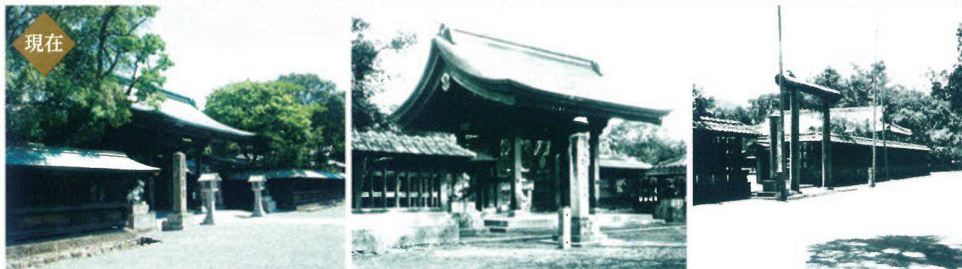
現在の神門は、大正15年(1926)に竣工したものです
