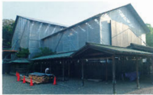
素屋根に覆われた本殿及び拝殿
