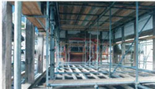
平成十七年に発生した福岡県西方沖地震により、床板に隙間が生じた為全部剥がして修復します。
