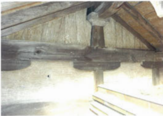
【拝殿外壁板】古胡粉は完全にに取り除き、塗り直す。
