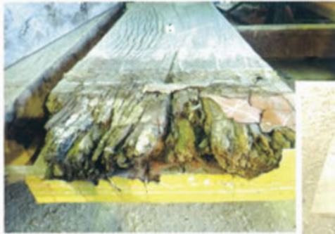
【縁板修復中】板先の腐朽が多く見られる。可能な限り、補修を行い再用に努めている。
