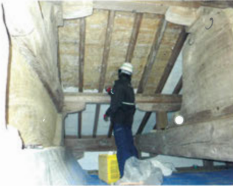
【拝殿内部】化粧裏板の掻き落とし作業中。
