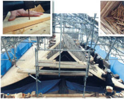
■葺替え作業中の拝殿
