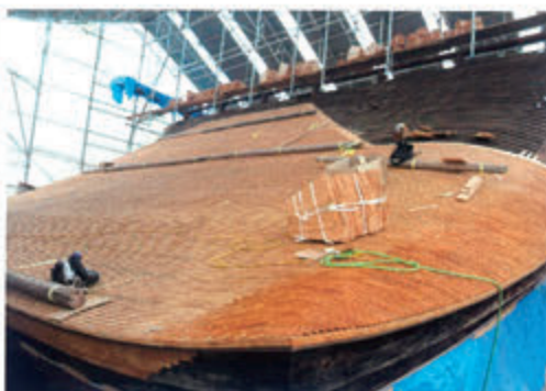
■本殿屋根平葺きは、軒先より板長さ 36cm、33cm、30cm と段階的に葺いています。
