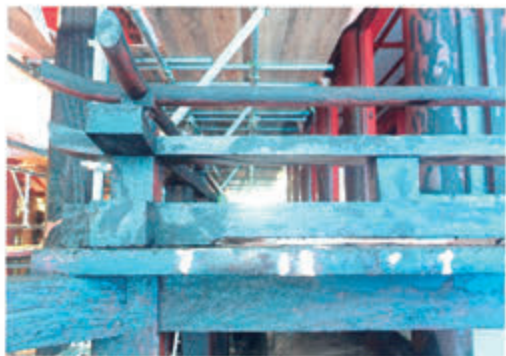
■塗装工事は、漆の木地固め(高欄や柱の黒っぽい部分)、刻苧(こくそ)かい【損傷部などを埋める作業】(緑板の白っぽい部分)が進められています。
