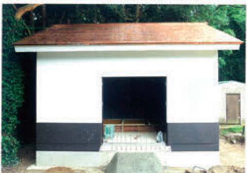
■5月から工事が始まった、消火用エンジンを収納するポンプ舎は、8月中旬に完成予定です。
