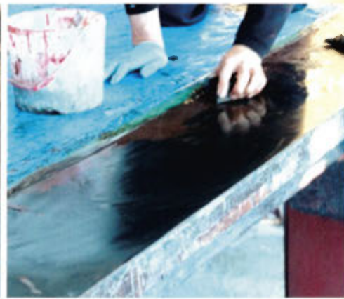
■本殿修復 縁板の木地を削って、平らにしています。この後、漆を塗ります。
