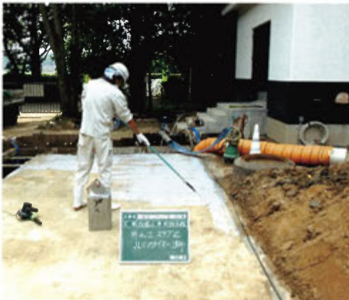
■防災事業 防火水槽には改めて防水加工を施し、継続して使用します。
