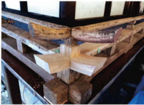
縁板の漆が塗り終わり、取り外して修繕していた高欄が取り付けられました。取り付けられた高欄は、これから漆を塗ります。
