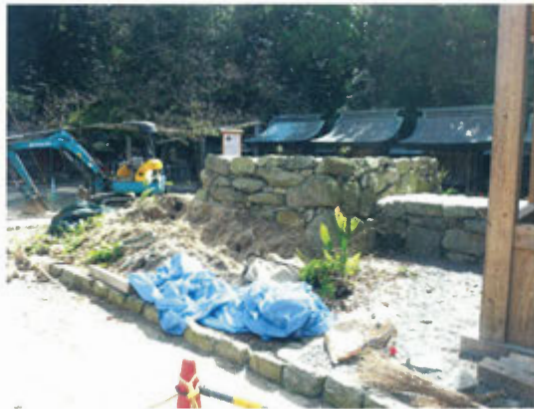
先ず、植栽を取り除いた
