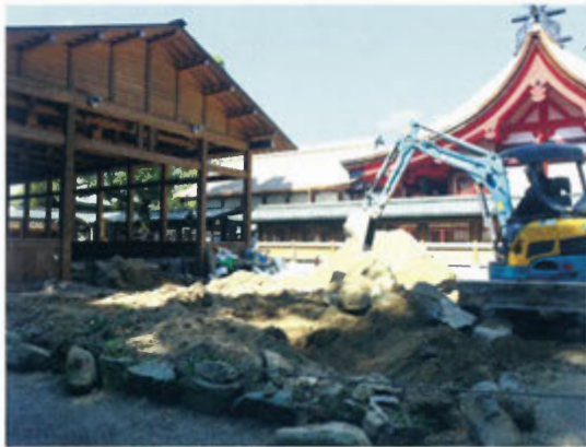
石積みを撤去した
