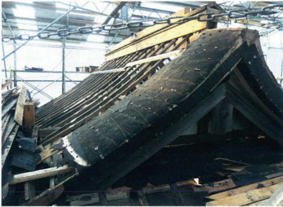
■屋根の解体が進む遙拝所
