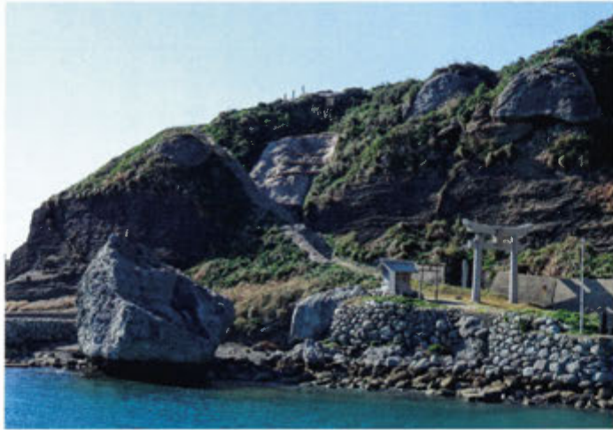
▲工事完了後の法面
