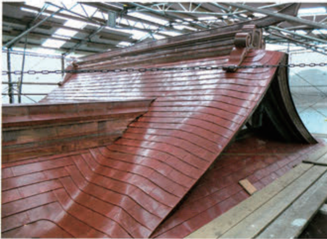
■葺き替えられた屋根
