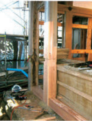
■文柱は根継ぎで修繕
