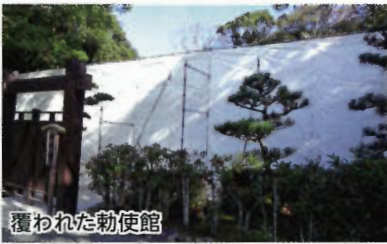
勅使館 (解体前)
